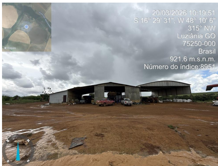
Figura 13 – Imagem da Fazenda Santo Antônio da Boa Vista, sendo identificado área com galpões e infraestrutura de apoio a máquinas agrícolas.
