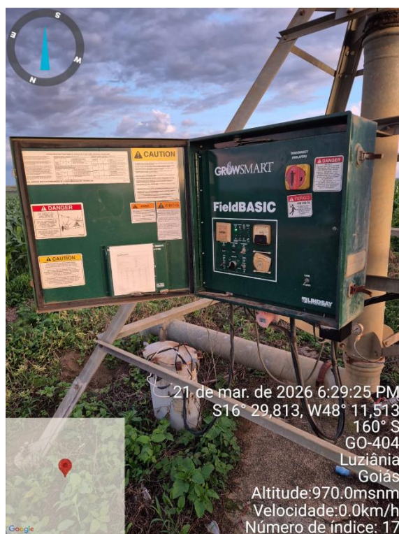
Figura 54 – Imagem do painel de controle, utilizado para planejar e programar o sistema de irrigação para aplicação de volume adequado de água na lavoura.
